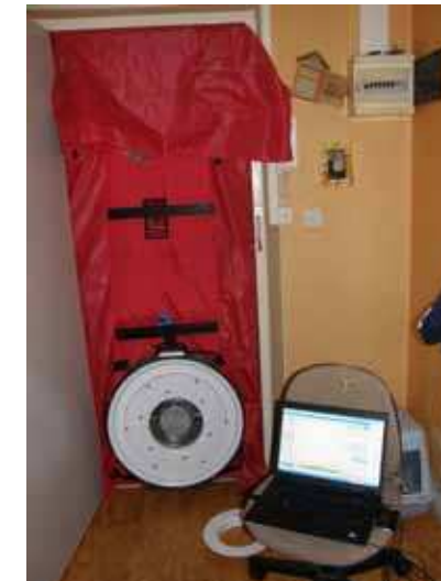
Test de perméabilité à l'air
