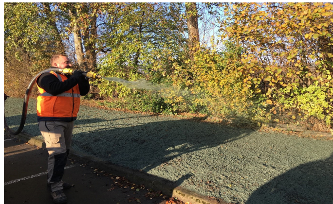
Application de l'hydro-seeding sur les abords du parking du lycée
