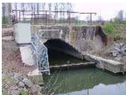
Lame déversante (pont des Vingt) et vanne (Fercotte)
