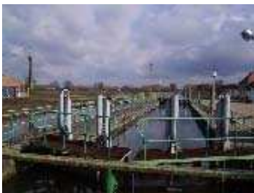
Ecluse de Warlaing
