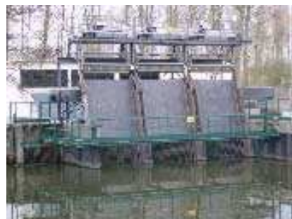
Stations de pompage (canal Broutin et Anguille)
