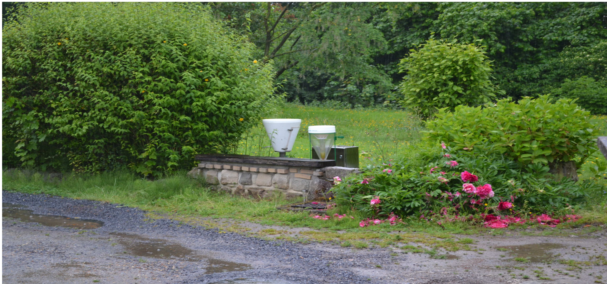
(Station pluviométrique SPC-DREAL de Borre)
