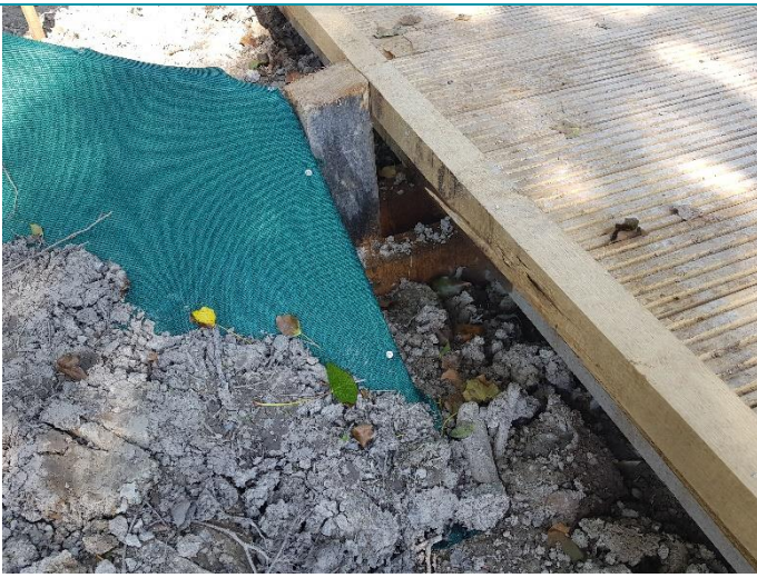
Jonction barrière/platelage à optimiser et chemin de VTT non condamné
