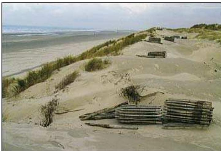
**Figure 21 : Alignement de fascines en bordure de dune (au premier plan : des ganivelles roulées non encore disposées), source mémoire de M. Suret, 2006**
