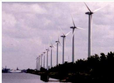
Développement en structuration - Canal de Zeebrugge (Belgique)
