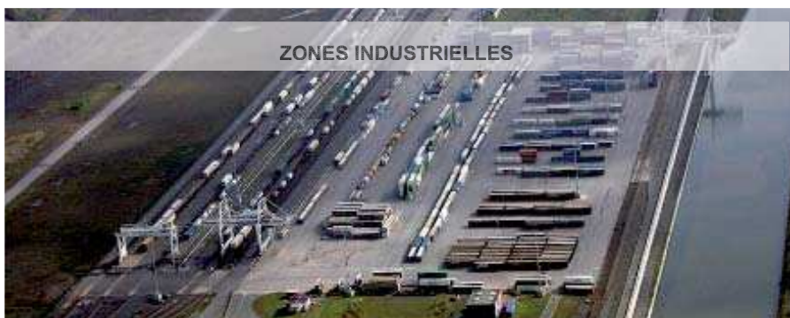
Plate-forme multimodale de Dourges.
