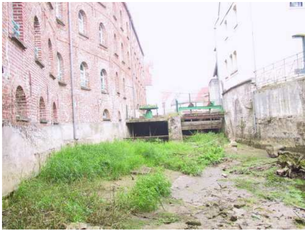
vue amont avant démolition
