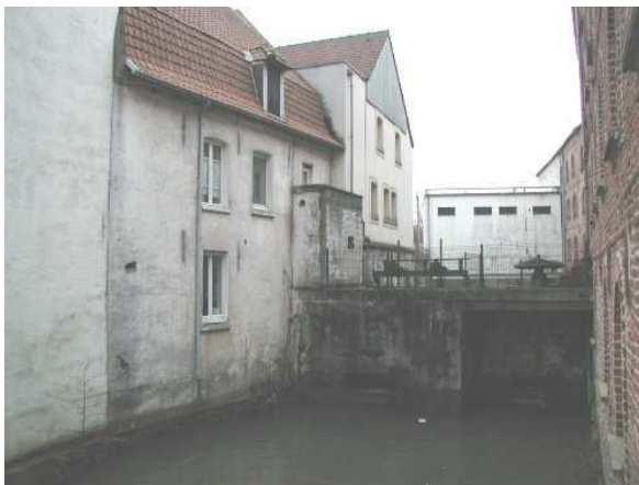
vue aval avant démolition
