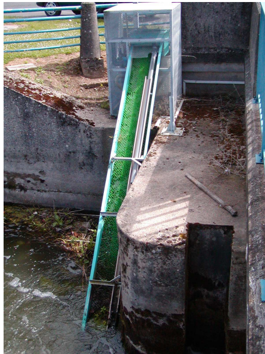
Passe-piège à civelles installée en 1999 sur barrage des six moulins, à Abbeville (Somme)
