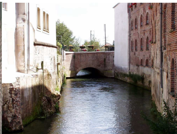
vue aval après démolition
