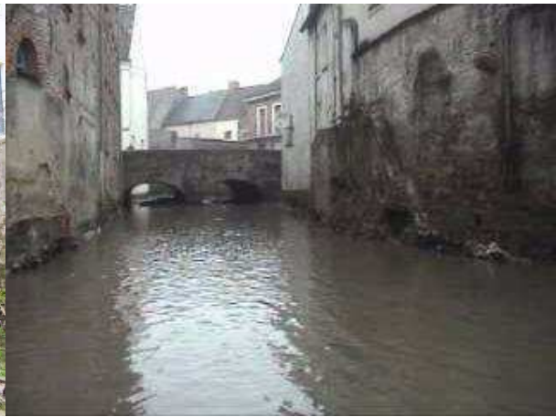
vue amont après démolition
