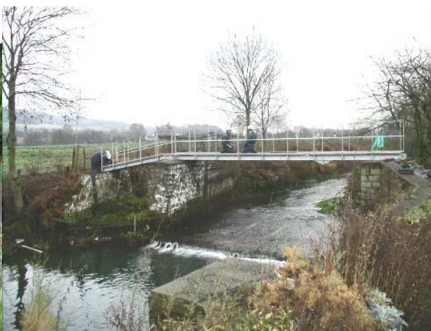
vue aval après démantèlement
