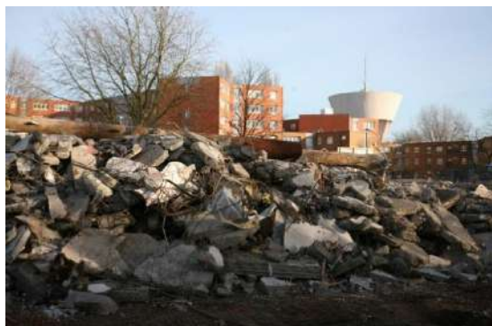
Démolitions au Banc-Vert
