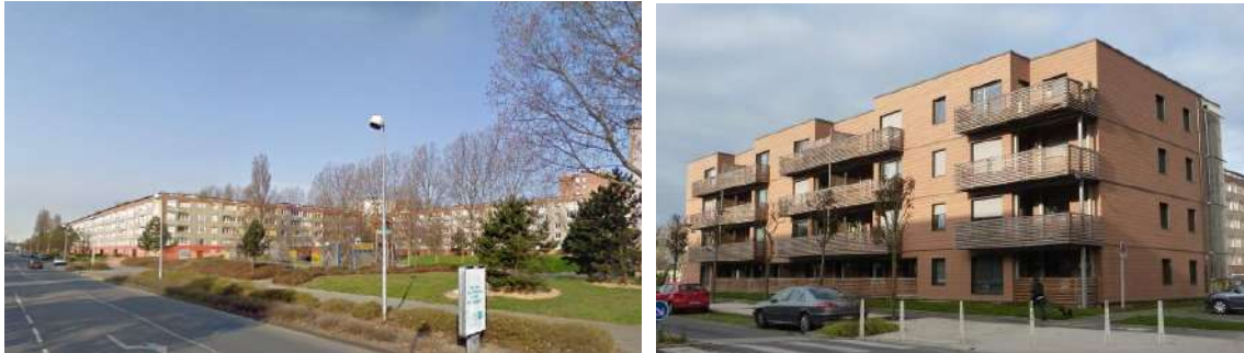
Avenue du Général de Gaulle - Avant - Après (source : ville de Grande-Synthe)
