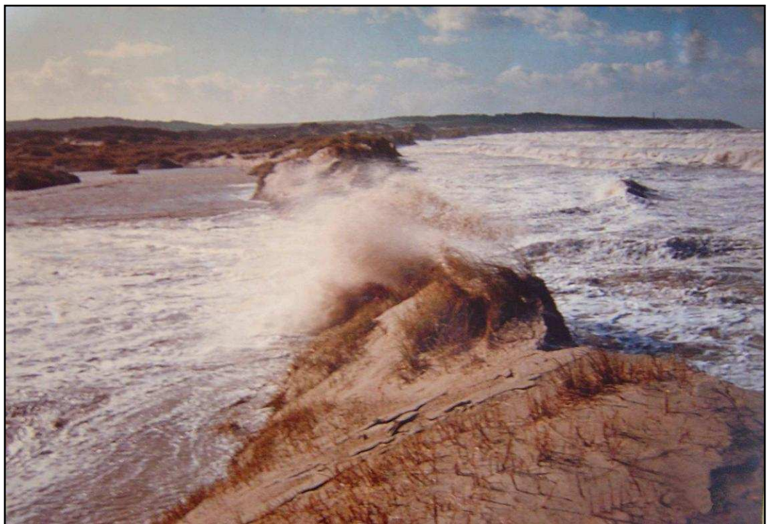
Figure 4-1 Rupture du cordon dunaire de Wissant en février 1990 (photo : O .Beaulieu)
