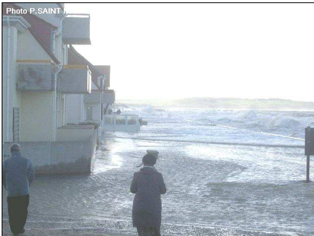
Figure 4-3 Franchissement du perré de Wissant en janvier 2007 (photo : P. Saint Maxent)
