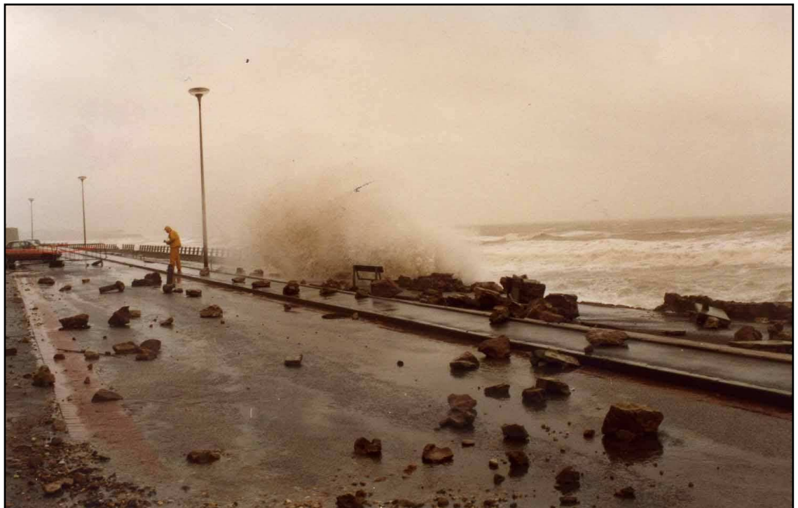
Figure 4-4 Franchissement du perré d'Ambleteuse en février 1990 Photo : DDE / SMBC)
