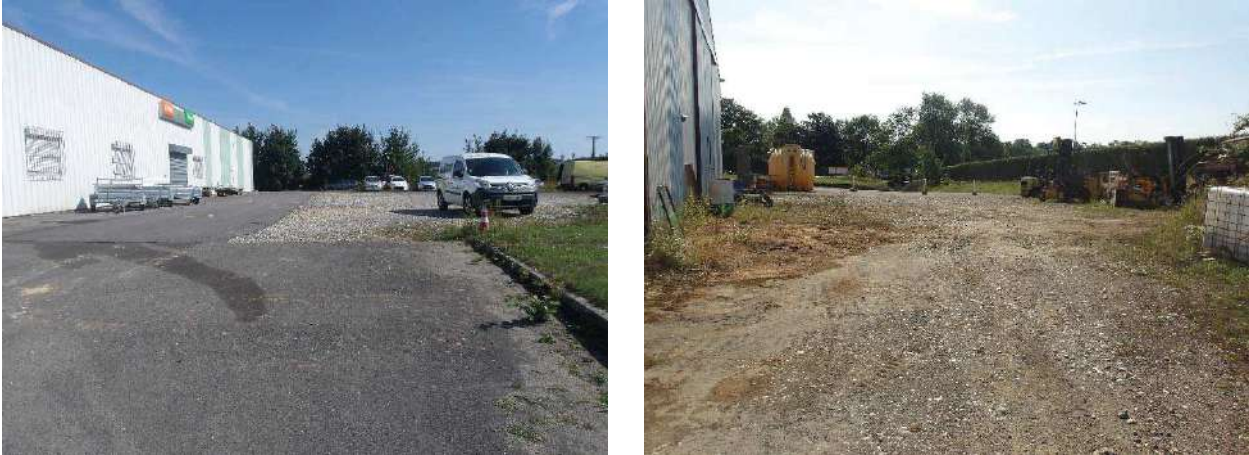
Vue sur les secteurs artificialisés du site d'étude
