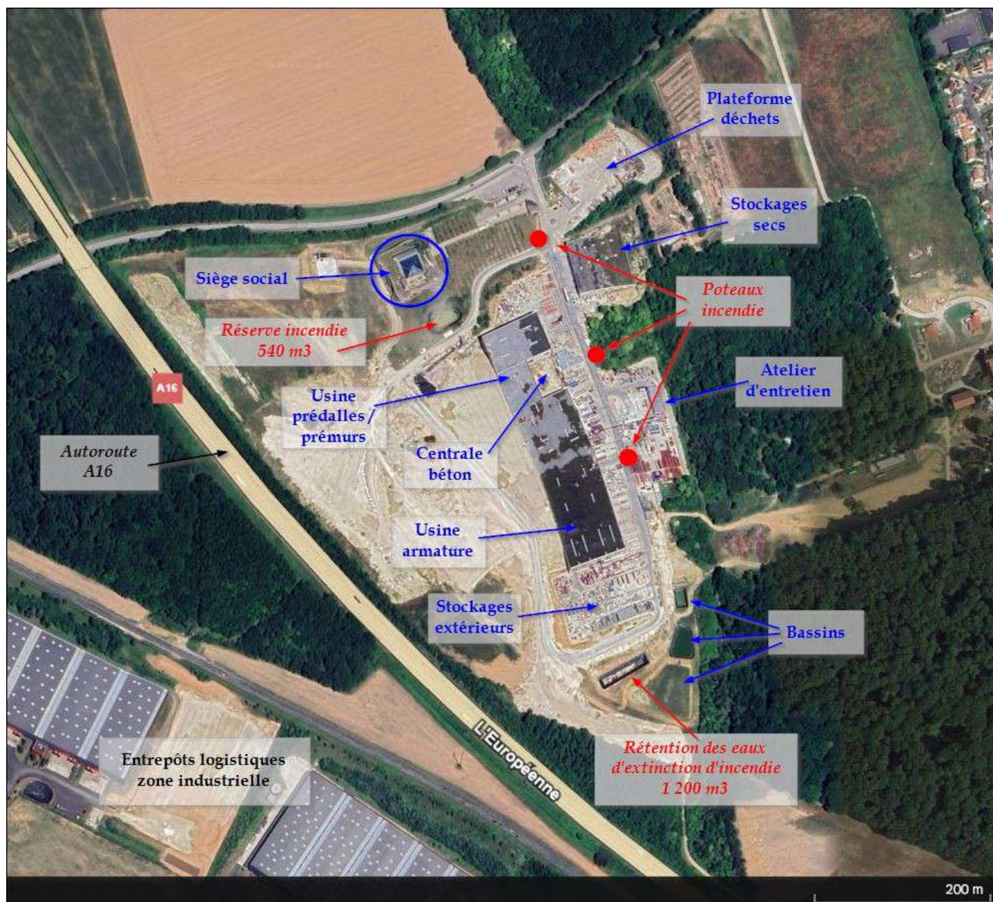
Illustration 5: Vue aérienne du site
