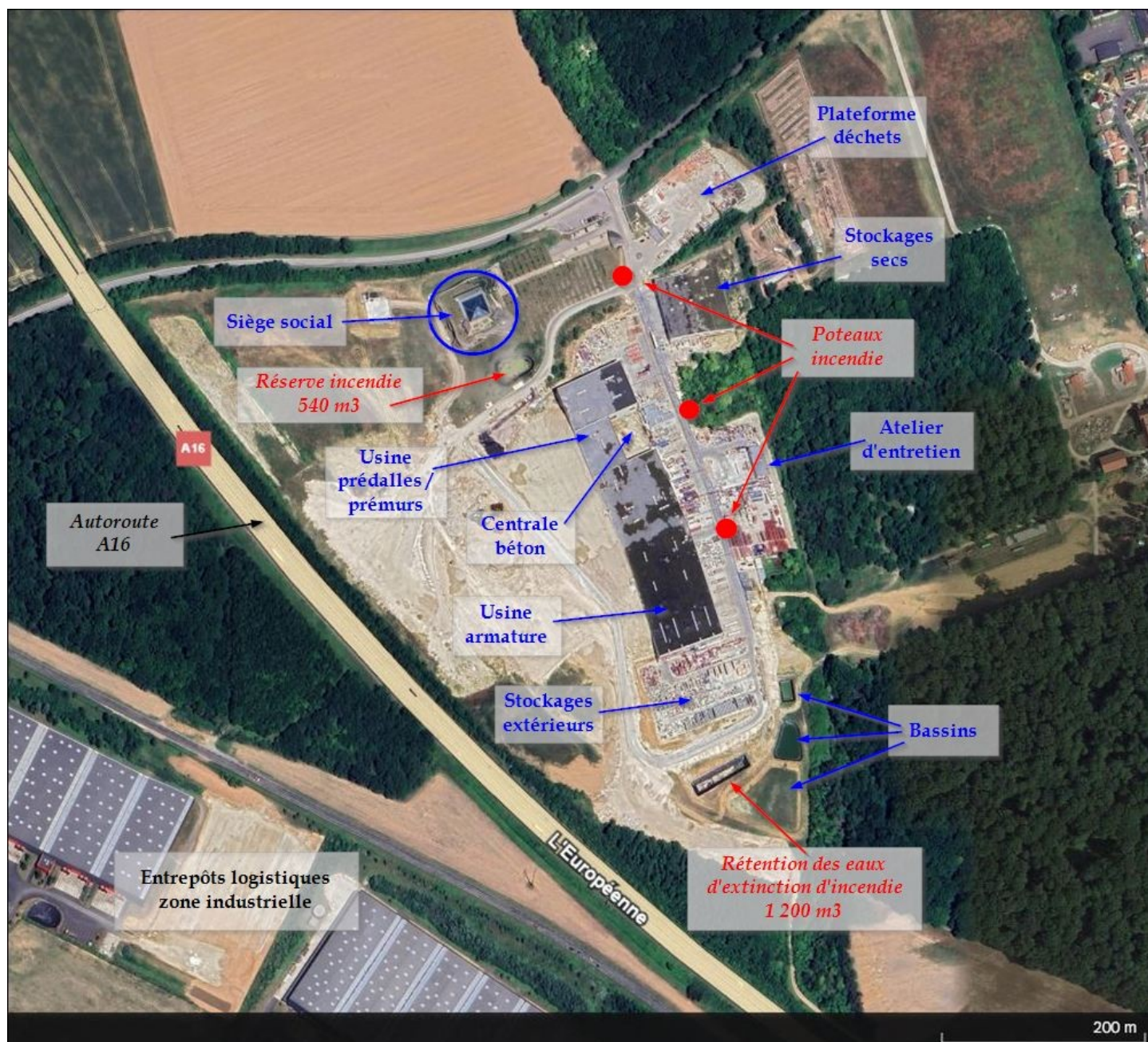
Illustration 5: Vue aérienne du site
