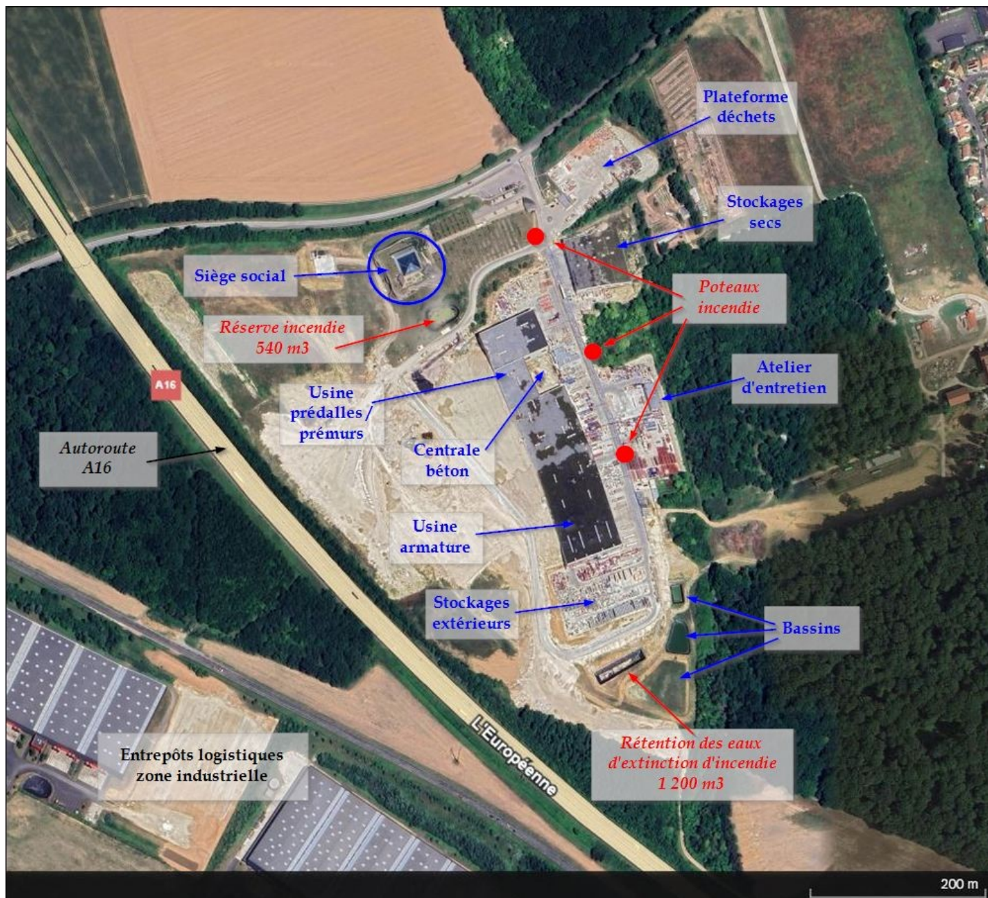
Illustration 2: Vue aérienne du site
