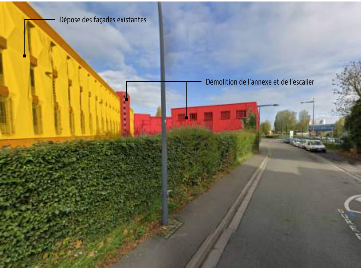
1. Vue depuis la rue du Moulin Delmar - Démolition de l'annexe
