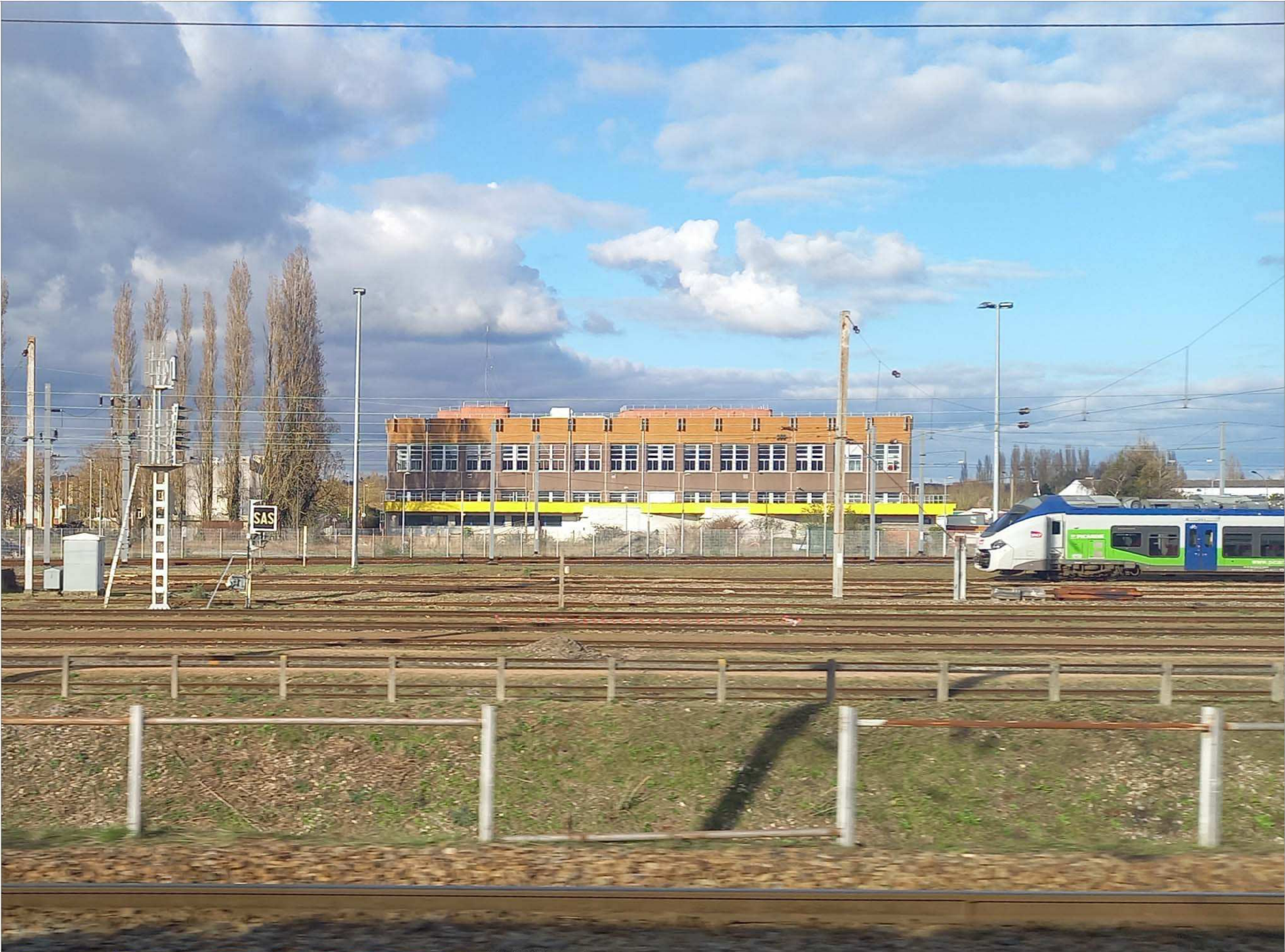
PHOTOGRAPHIE N°1 - vue depuis les voies SNCF
