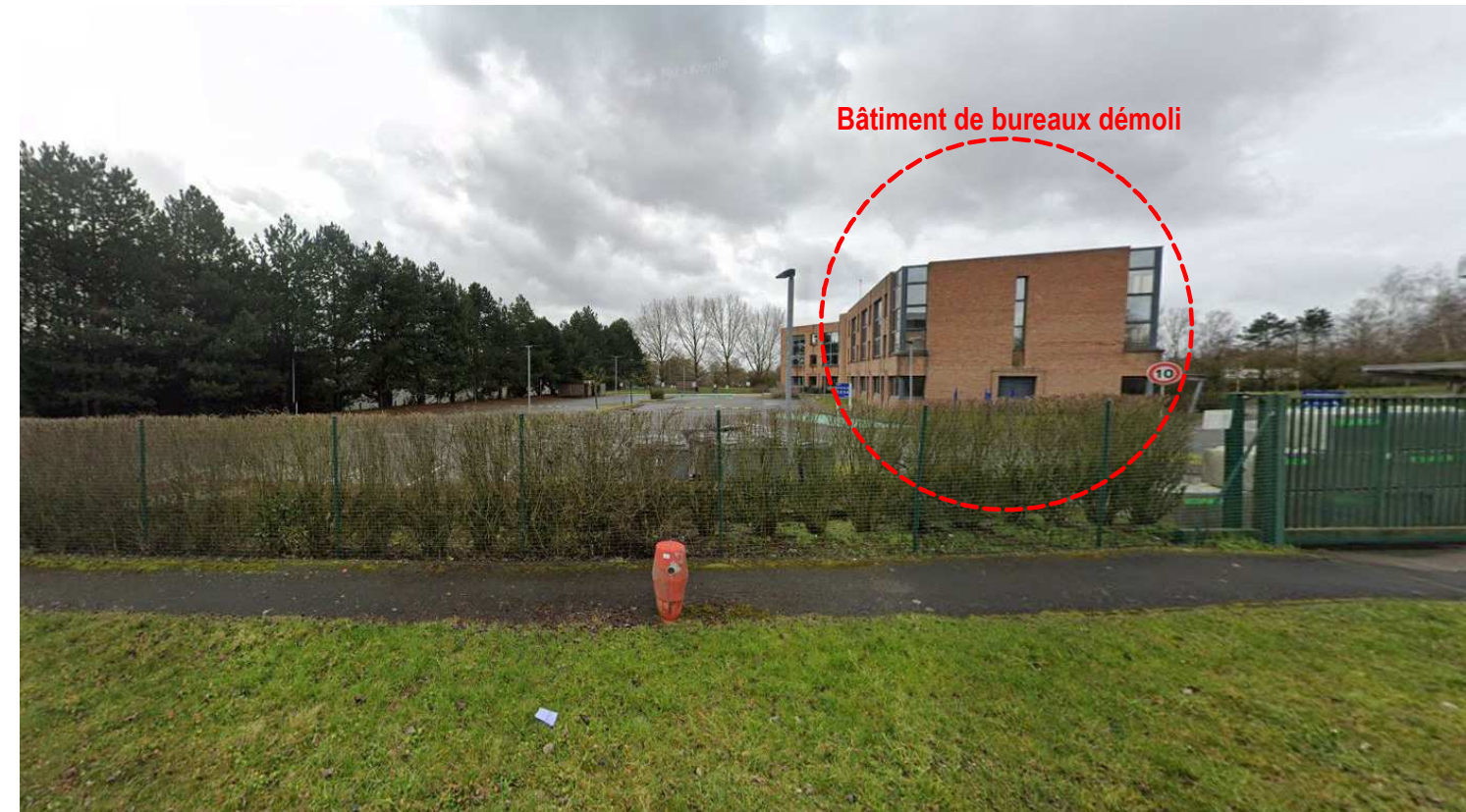
Vue 2_photographie vue proche AVANT démolition du bâtiment de bureaux
