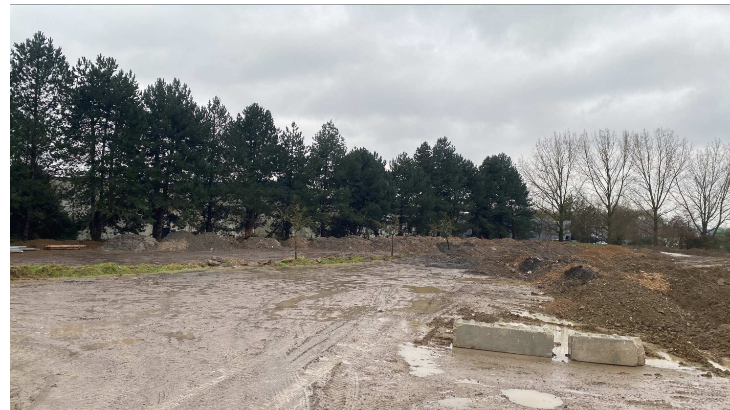
Vue 3_photographie vue proche APRES démolition du bâtiment de bureaux
