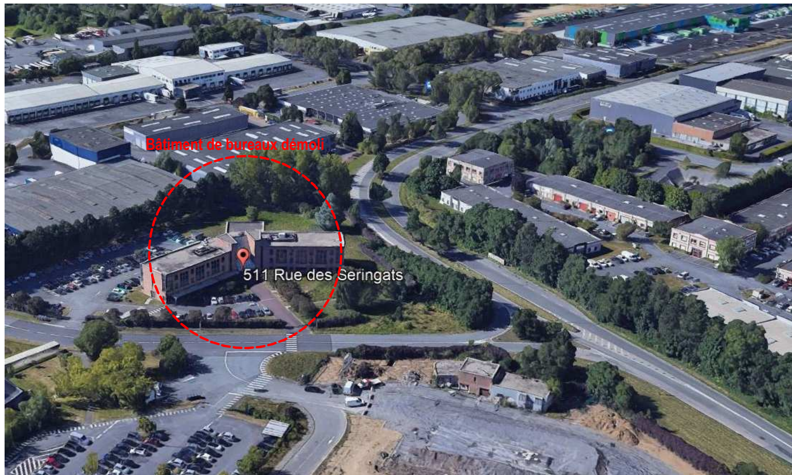
Vue 1_photographie vue lointaine AVANT démolition bâtiment de bureaux
