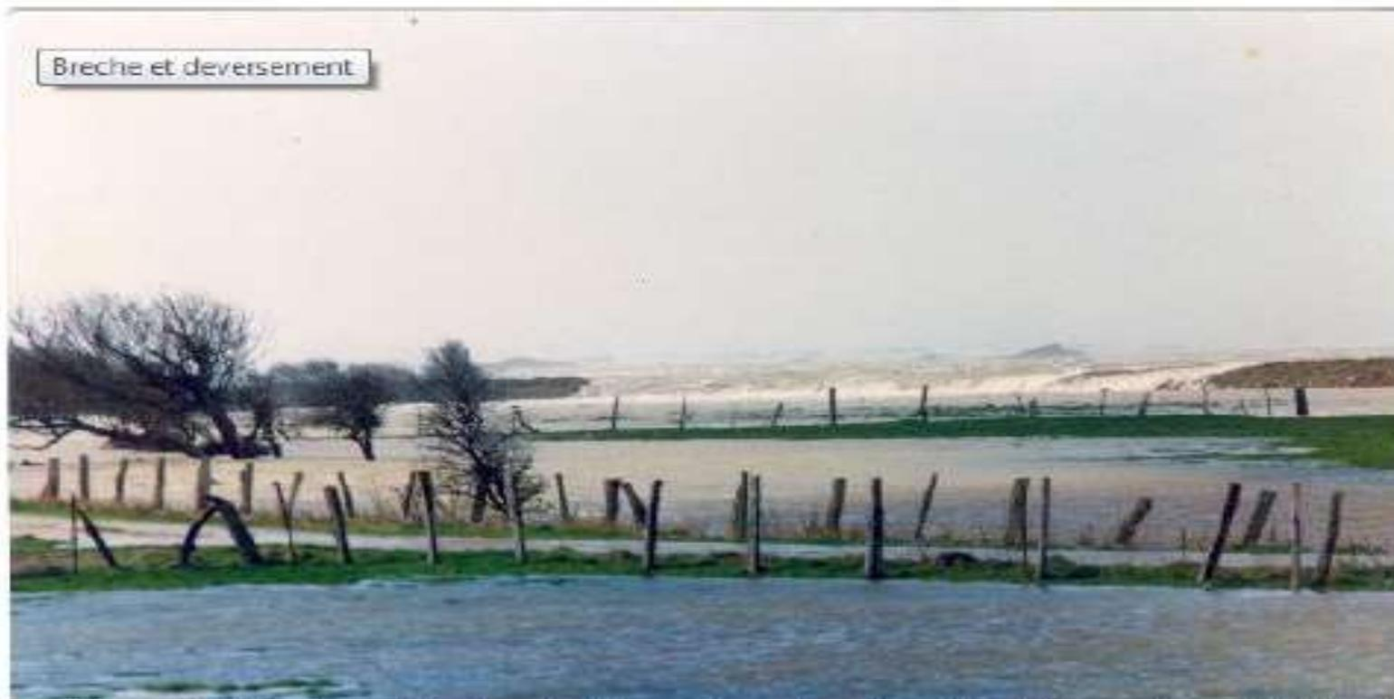
Figure 22 : Photographie d'une brèche sur le cordon de galet de Cayeux lors de l'épisode de submersion de 1990. Source : Cayeux-citoyens
