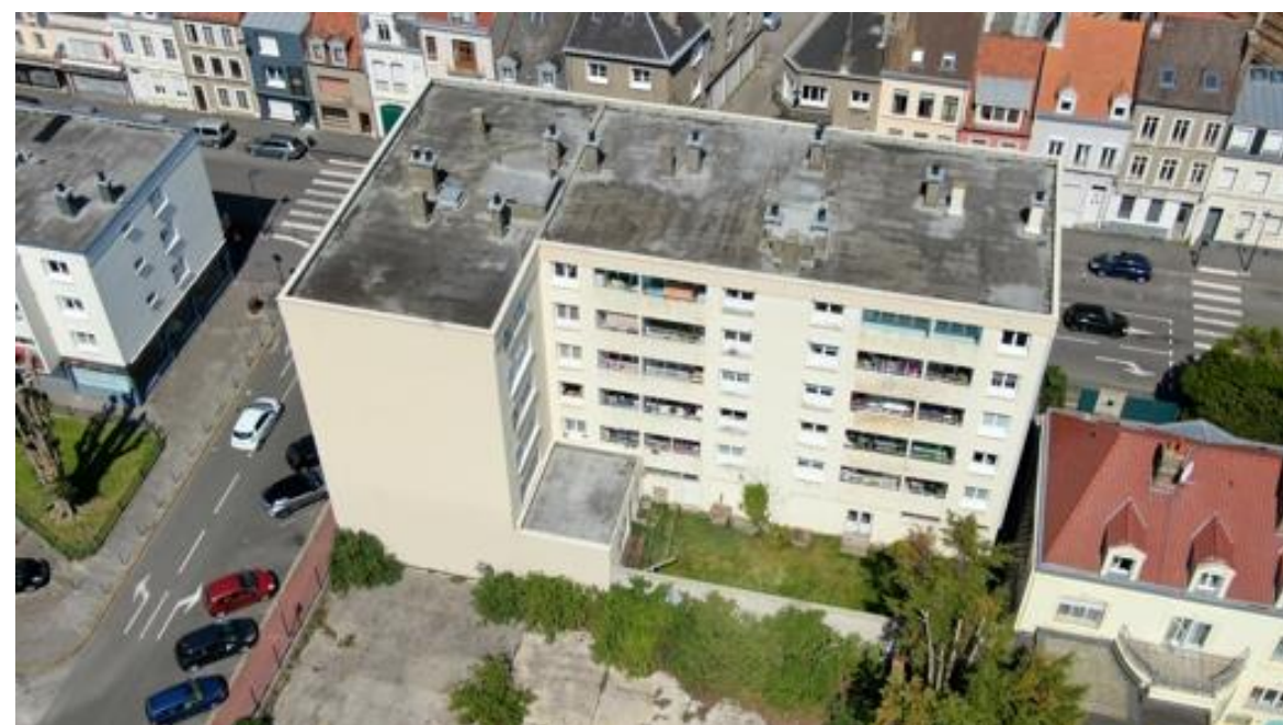
VUE LOINTAINE N°2 Vers le nord, et le nord du site : 1 er plan : la partie nord du terrain ; Second plan : l'immeuble du 46 et 48 rue Edmond-Hédouin et 146 rue Nationale, sur ma parcelle voisine AE-282.
