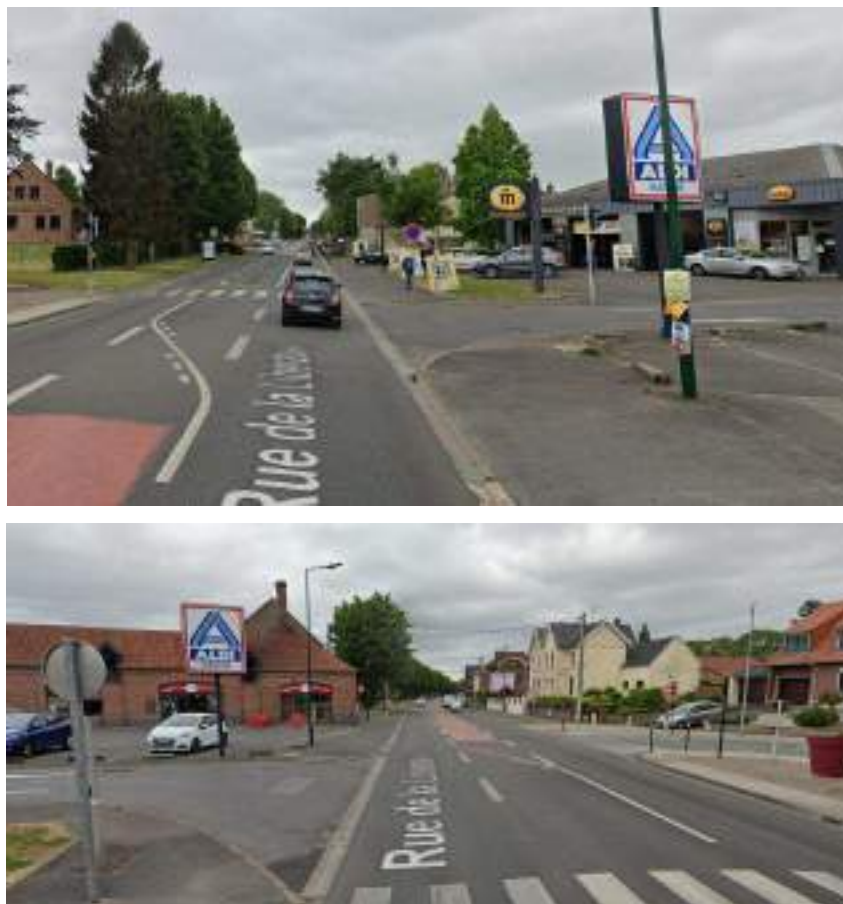
Figure 47 : Prise de vue de la RD841 – Source : google maps
