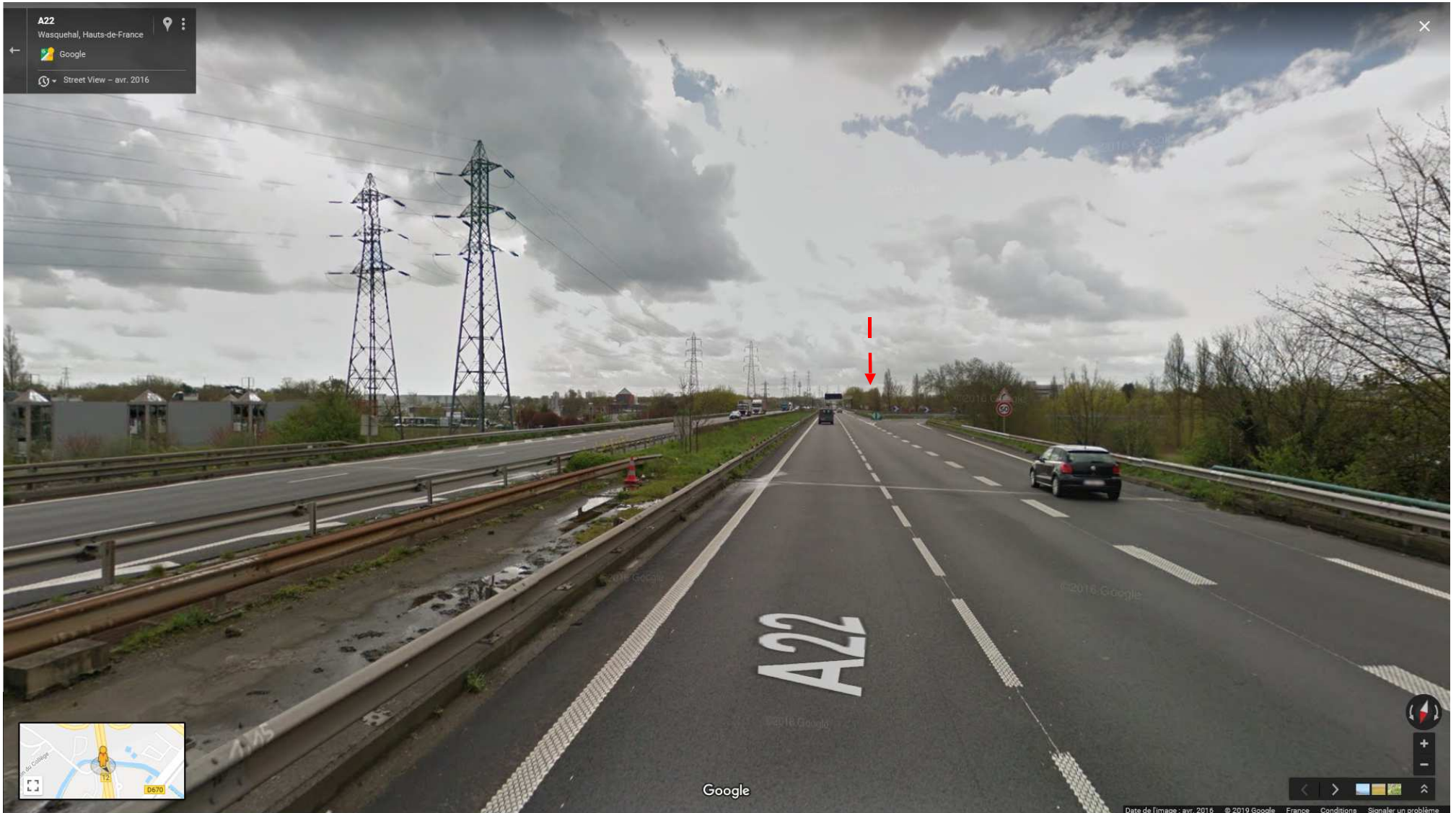
1 - Depuis l'A22 : le site est à peine perceptible dans cet environnement où les masques visuels sont nombreux, d'autant que la vitesse des véhicules n'offre pas de vues prolongées (source : Google, avril 2016)
