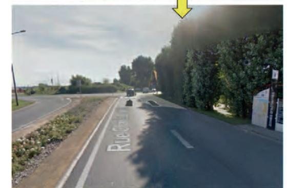
Le passage d'une voie à deux voies d'entrée sur la RD601 nord permettra comme indiqué dans l'étude initiale d'améliorer la réserve de capacité de la branche et le fonctionnement générale du giratoire.
