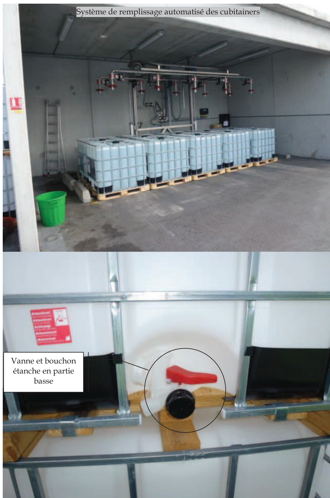
Figure 3 : Système de remplissage automatisé et vanne en partie basse d'un cubitainer
