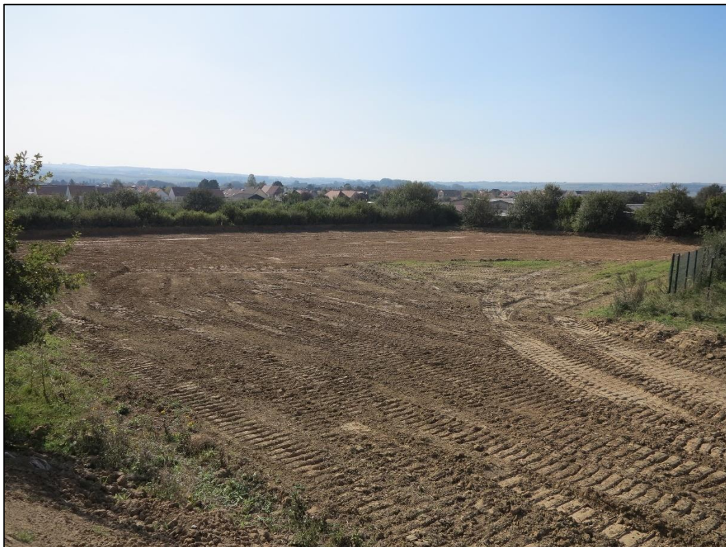
Photo 1 – Vue d'ensemble de la zone décapée
