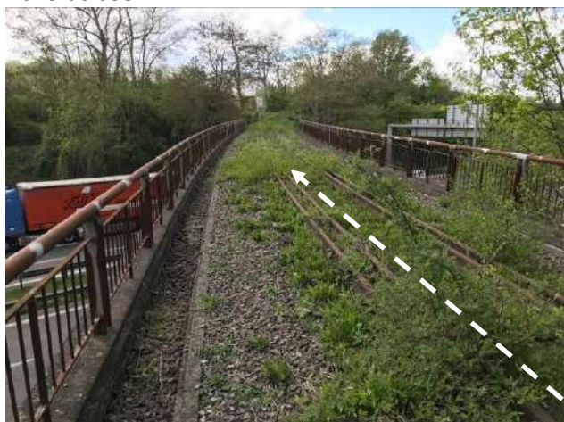
7/ Passerelle sur l'A21
