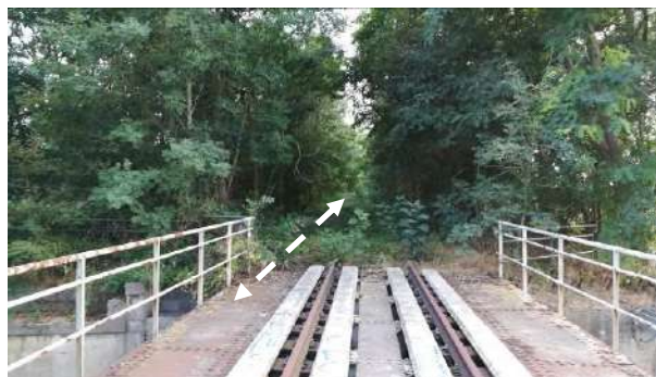
10/ Pont du Chemin de Béthune à Douai
