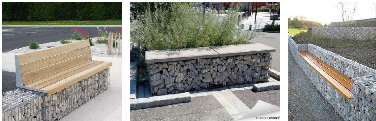
Figure 19 : Exemple de bancs en gabions
