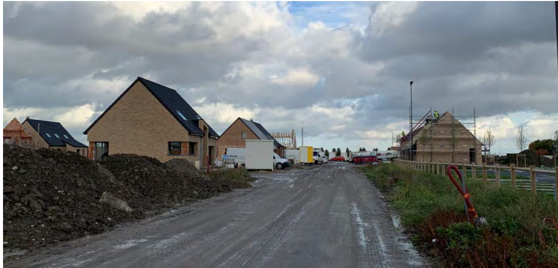
Figure 7: Construction d'un projet mixte à l'est du projet
