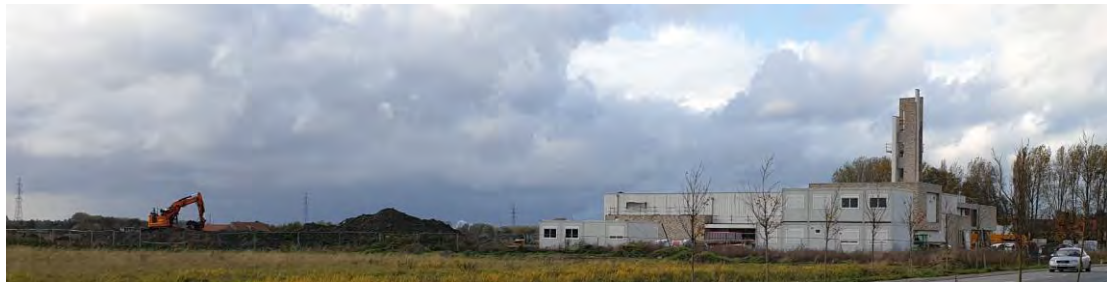
Figure 5 : Travaux de construction de la future mairie en cours
