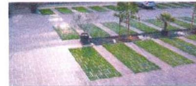
TTE-Multidrain préserve la capacité d'infiltration des eaux pluviales, véritable réservoir tampon en cas de fortes précipitations.
