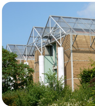
© CRAterre, T. Joffroy - Mur en terre
