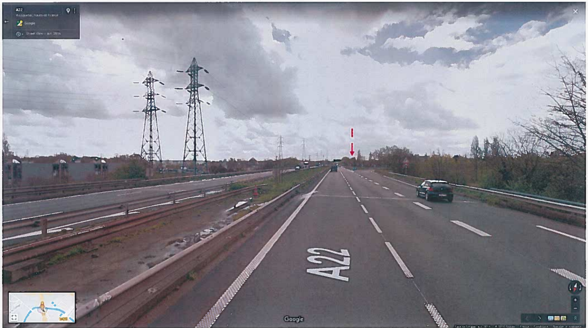
1 - Depuis l'A22 : le site est à peine perceptible dans cet environnement où les masques visuels sont nombreux, d'autant que la vitesse des véhicules n'offre pas de vues prolongées (source: Google, avril 2016)
