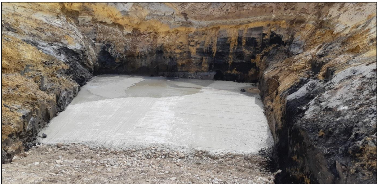
Figure 8 : Dalle béton finale
