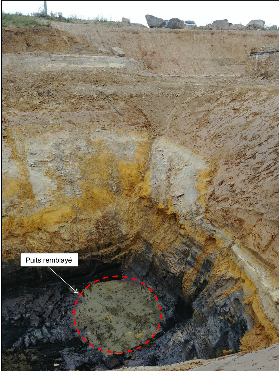
Figure 5 : Photo du puits FP14
