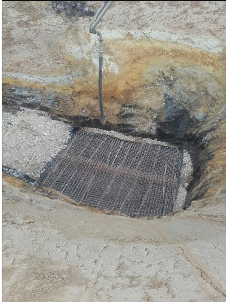
Figure 7 : Armature métallique de la dalle béton posée à l'aplomb du puits
