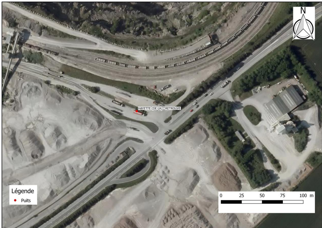
Figure 11 : Suppression de l'aléa effondrement localisé sur le puits de La Hayette APRES mise en sécurité
