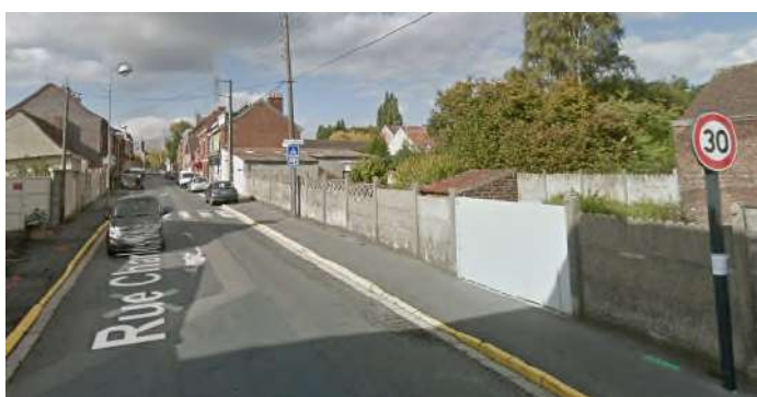
Figure 3 : Entrée Sud du quartier
