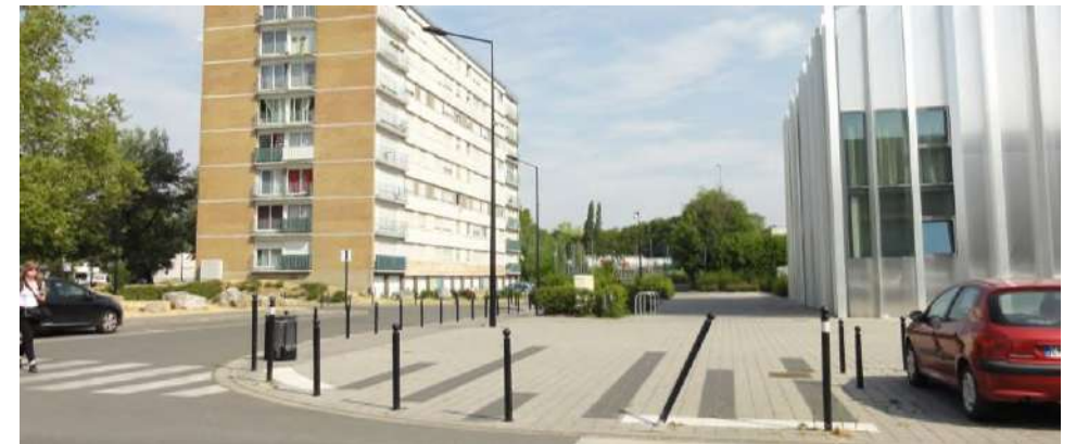
2_ Accès à la traverse piétonne et cycle vers le tramway – Mauvais visibilité liée aux stationnements
