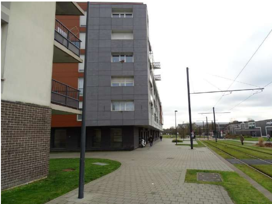
Logement Collectifs à Denain – Source : Verdi
