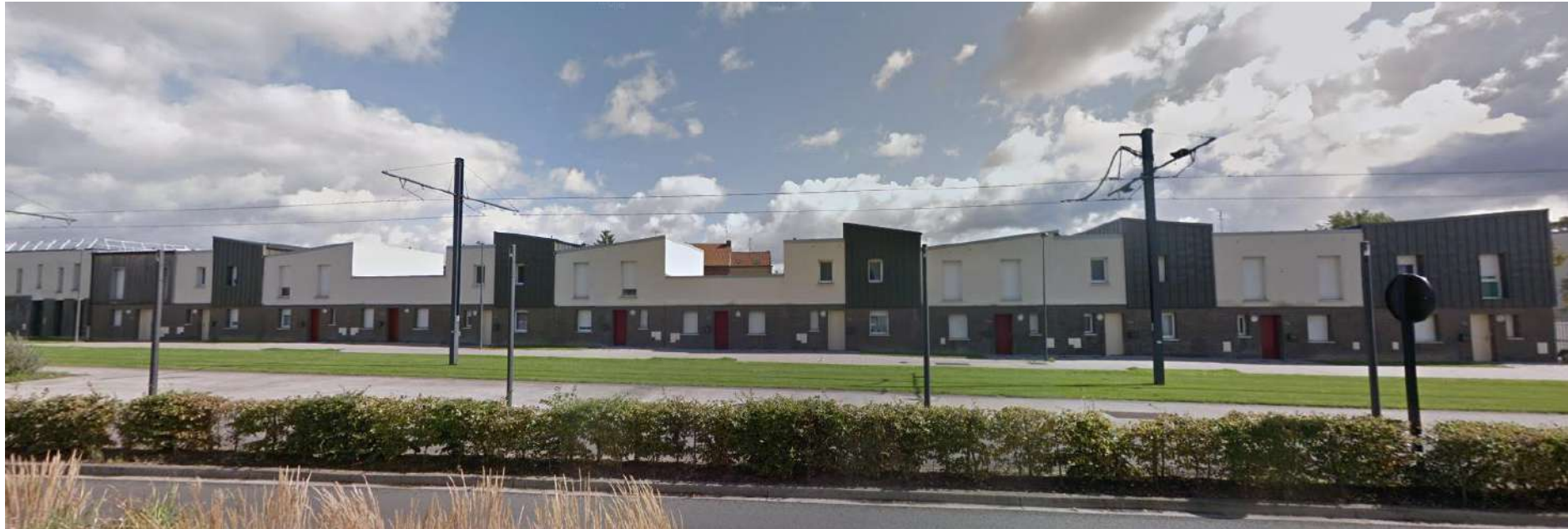
Maisons de ville à Denain – Source : Google Maps
