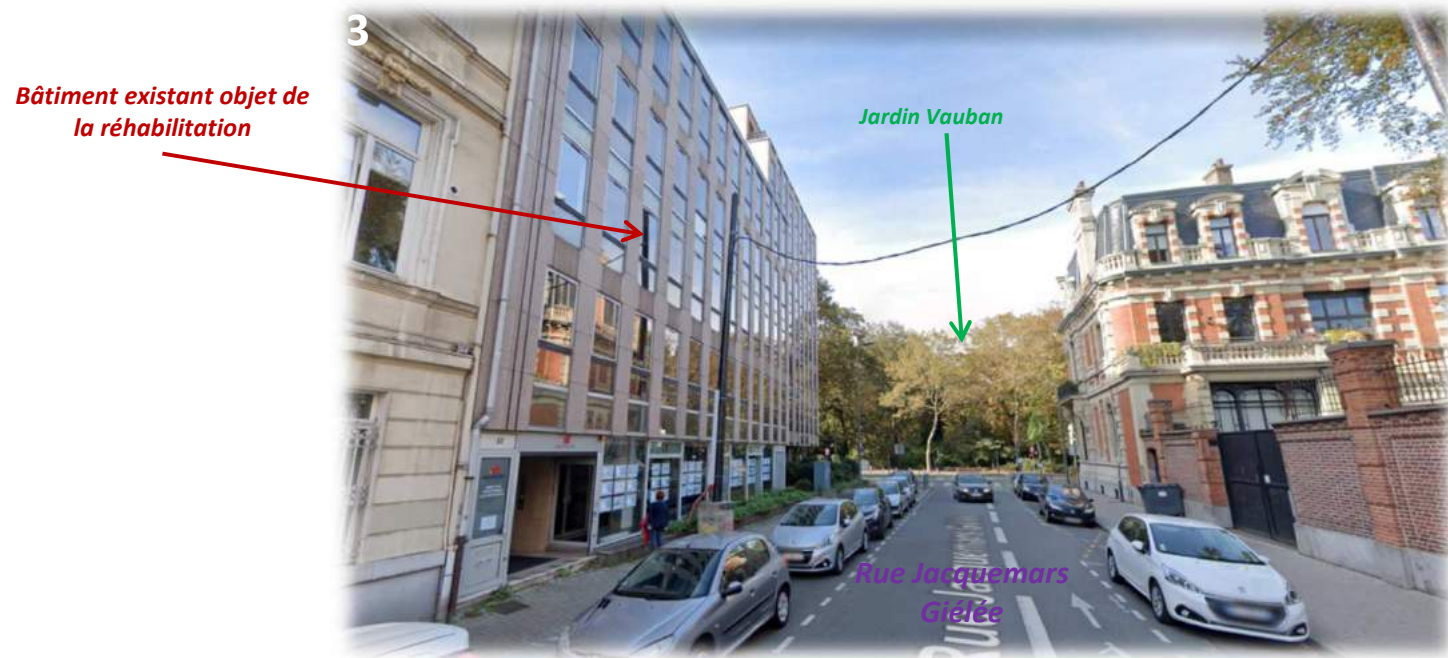
Vue sur le bâtiment à réhabiliter depuis la Rue Jacquemars Giélée (bâtiment installé à l'angle du Boulevard Vauban et de la Rue Jacquemars Giélée)
