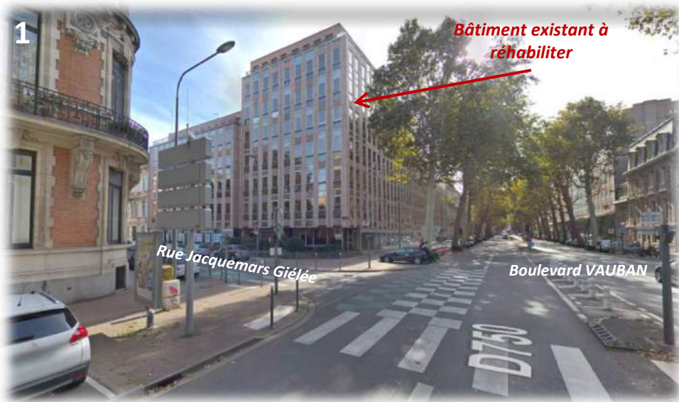
Vue sur le bâtiment à réhabiliter depuis le Boulevard Vauban
