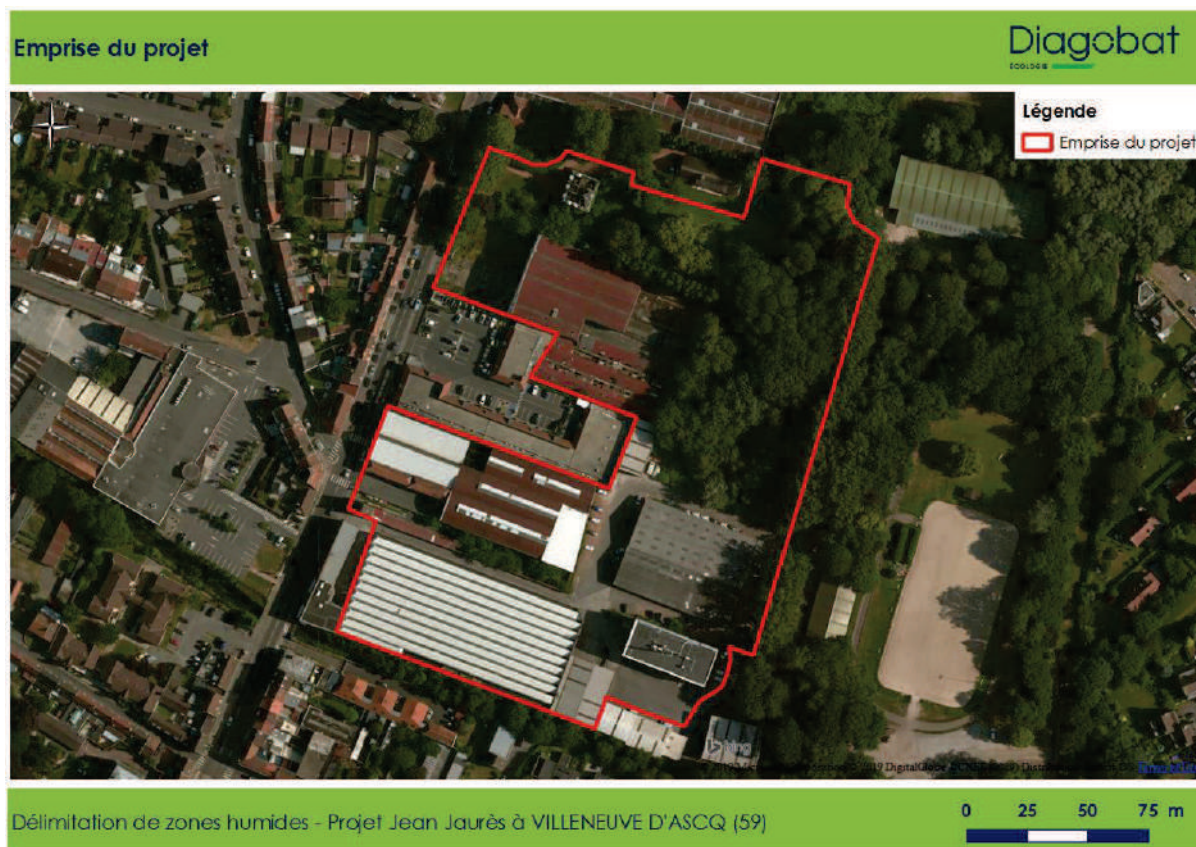
Photographie aérienne du site (fond satellite de Bing Aerial)
