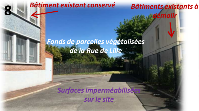
Vue depuis l'intérieur du site entre les bâtiments existants vers la limite Nord-Est (fonds de parcelle de la Rue de Lille)
