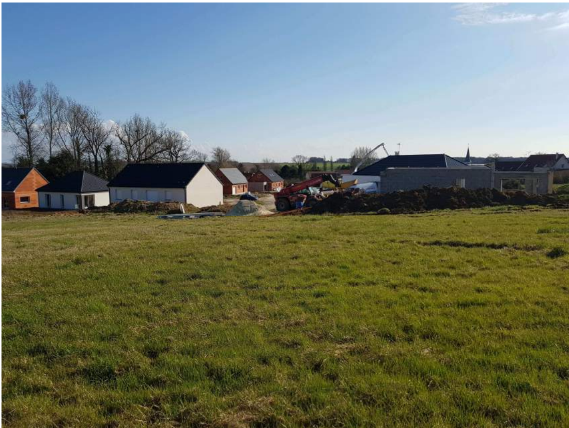
Photo 6 : Vue de la tranche n°1 depuis le Nord de la zone à aménager vers le Sud (2018)
