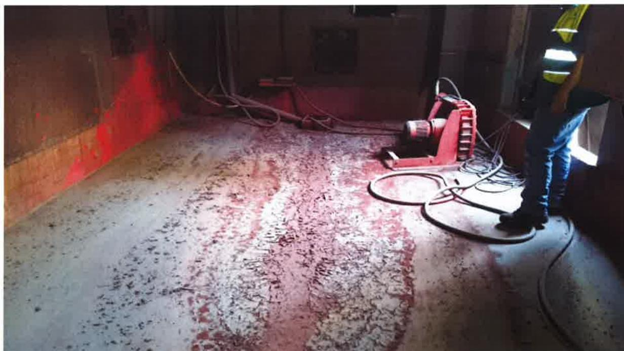
**Figure 6 : Salle de récupération des égouttures ou fuites de produits de traitement - sur rétention**
