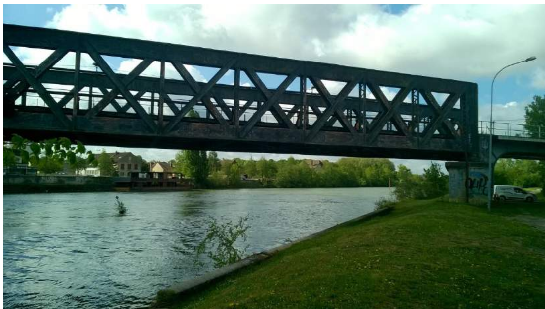
Fig. 12. Vue de l'Oise à proximité du site et pont de la voie ferrée
