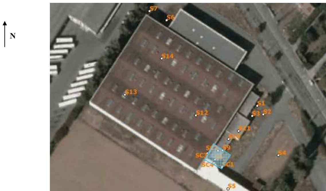
Illustration n° 2 : Localisation de la source concentrée en trichloroéthylène (Source : BRGM, échelle approximative 1/1200 e )
