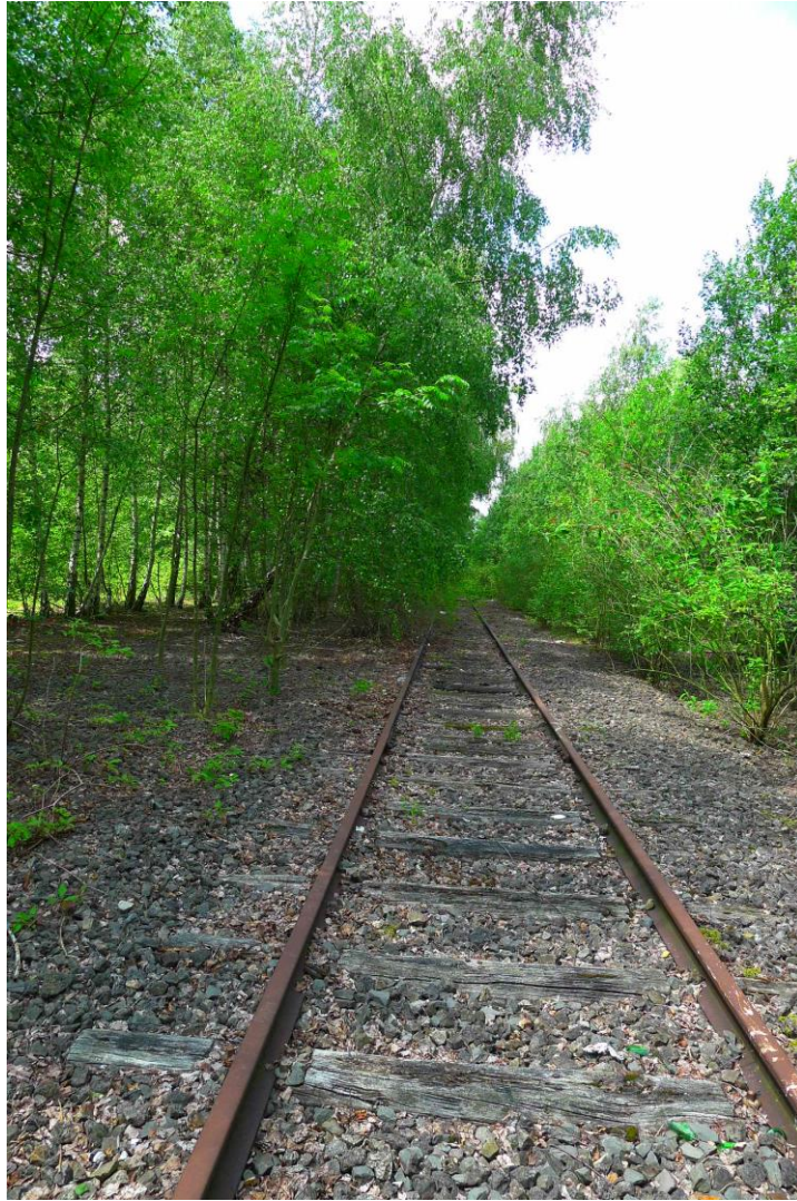
Légende : au niveau de la chaussée Albert Einstein à Tourcoing (avant enlèvement des rails et enterrement du réseau de chaleur)
