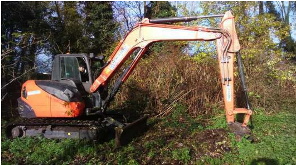
Figure 9 : Réalisation de fouilles à la pelle mécanique
