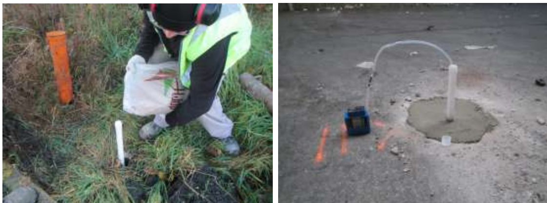
Figure 11 : Implantation des piézairs et prélèvements des gaz du sol
