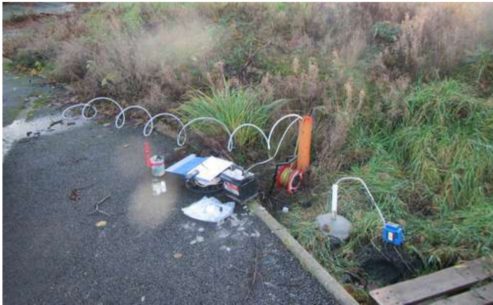
Figure 10 : Prélèvement des eaux souterraines et rejet via un filtre à charbon actif
