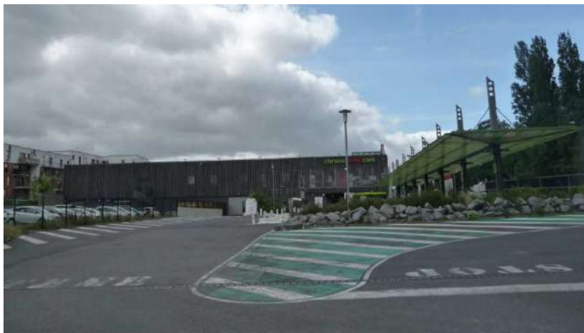
Photo C - Vue du site (Nord vers Sud)
