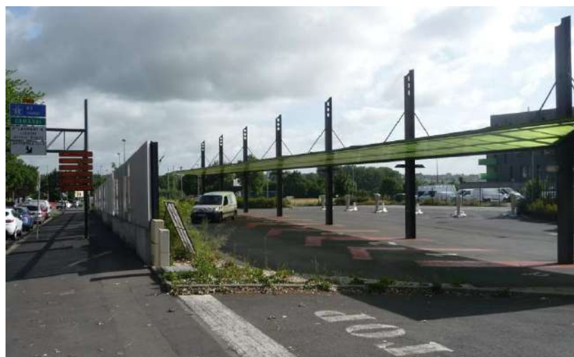
Photo D - Vue du site (Sud vers Nord)
