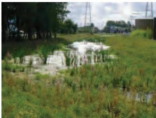
Les eaux pluviales de voiries et parkings seront collectées par des noues implantées entre les lignes de parkings. Ces noues permettront également le filtrage et la décantation des eaux avant rejet aux bassins.
