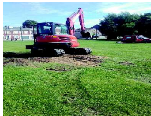
PM8 (Rebouchage de la fouille)
