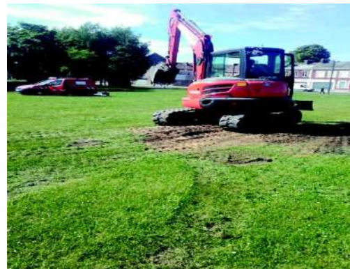
PM9 (Rebouchage de la fouille)
