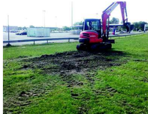
PM6 (Rebouchage de la fouille)
