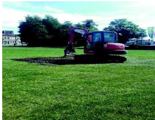
PM7 (Rebouchage de la fouille)
