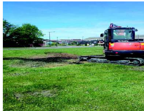
PM1 (Rebouchage de la fouille)
