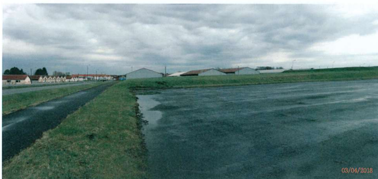
04 Bâtiments 0059 0060 Vue depuis accès parking 0222
