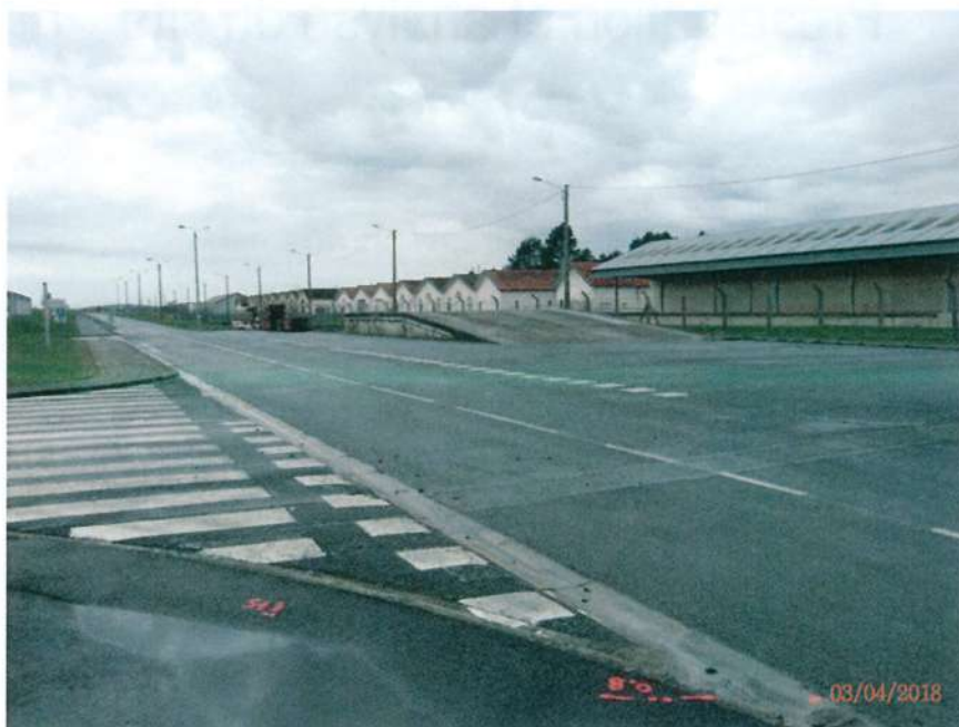
01 Quai débarquement voie ferrée
