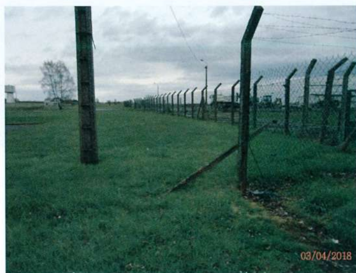
13 Rue des chars vers terrain de manœuvre.
