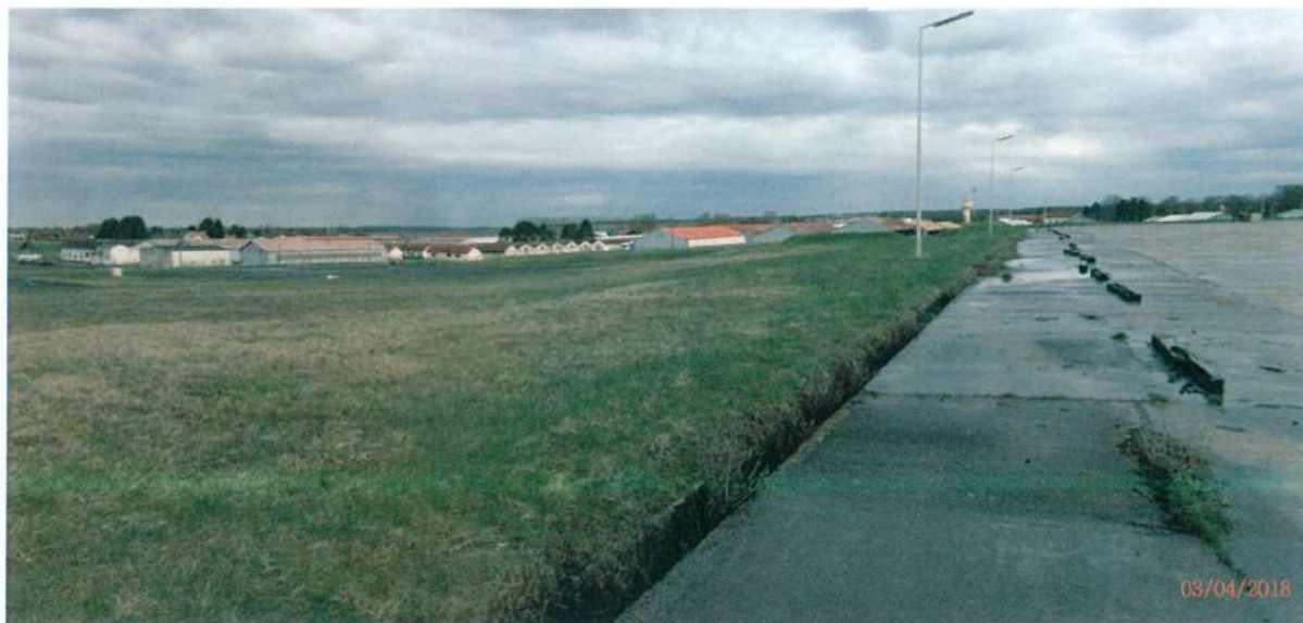
06 Vue depuis parking 0197
