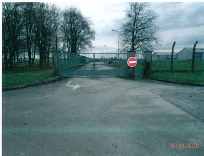
11 Rue des chars vers ZED existante :
