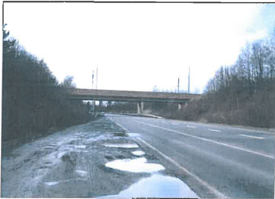
Boulevard du Petit Quinquin - passage de la voie ferrée
