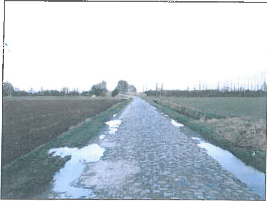
Vue sur l'autoroute A23 - chemin des loups
