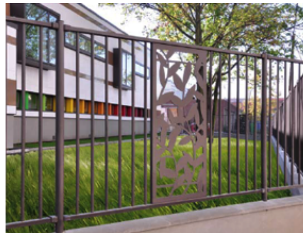
Clôture barreaudée ht 1,50m avec insert tôle découpée servant de support aux plantes grimpantes > Créer des animations
