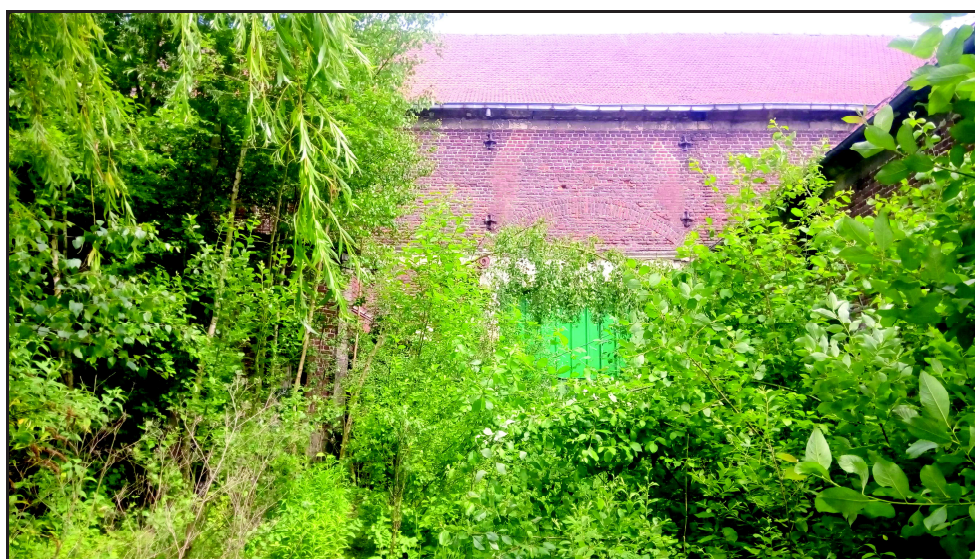
Fig. 1. Photographies du site du projet.
