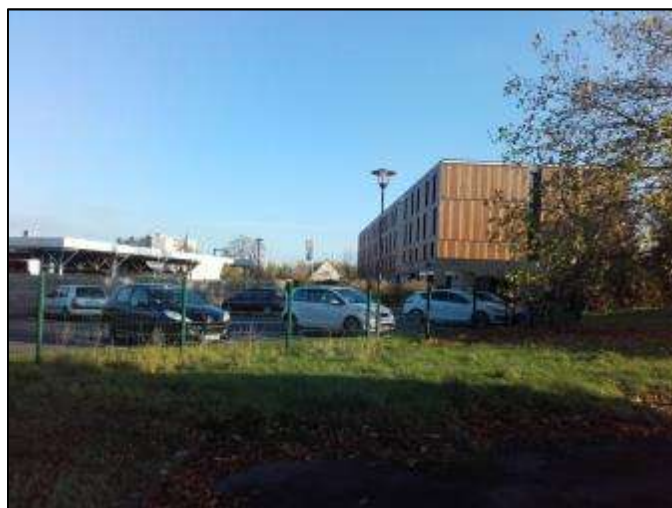
Photographie 10 : Vue de la résidence étudiante en limite est du site
