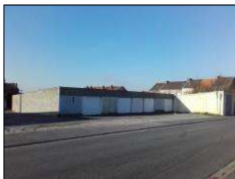
Photographie 5 : Boxes de stationnement en limite ouest du site
