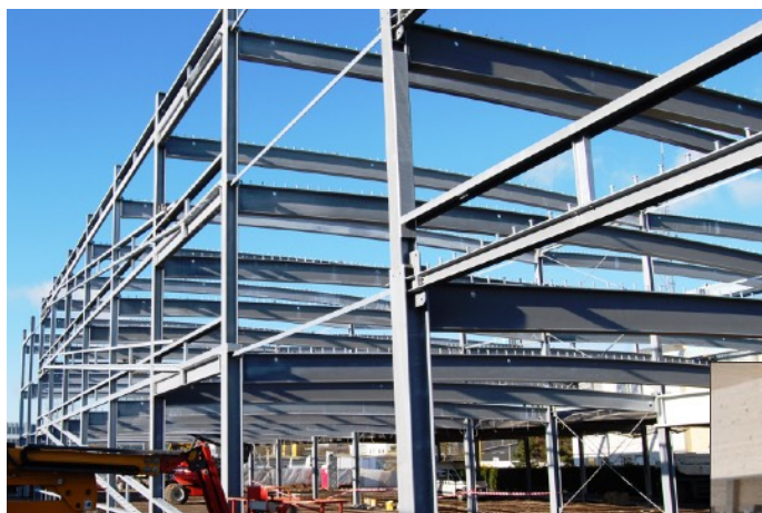
Ci-dessus un exemple de parking en structure métallique en cours de construction
