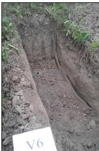
Vue n°107 : vue du sondage V6
