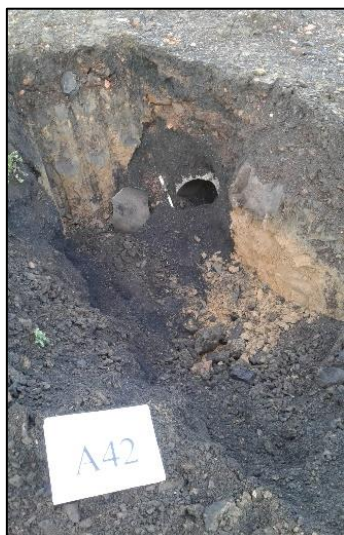
Vue n°75 : vue du sondage A42
