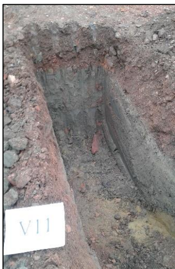
Vue n°117 : vue du sondage V11
