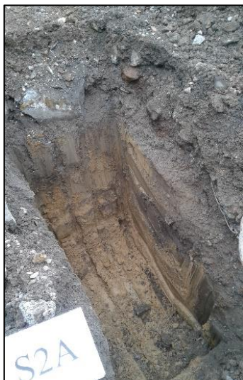
Vue n°79 : vue du sondage S2A
