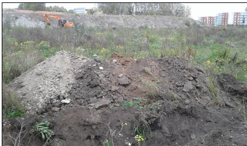
Vue n°124 : vue des déblais de la fouille V16
