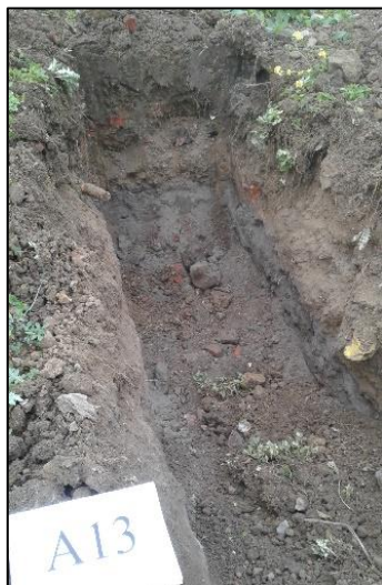
Vue n°25 : vue du sondage A13
