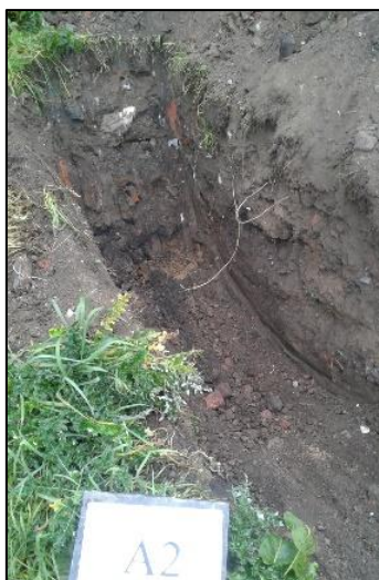
Vue n°3 : Vue de la fouille A2
