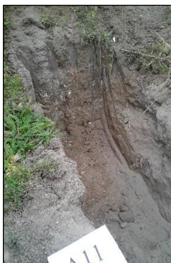
Vue n°21 : Vue de la fouille A11
