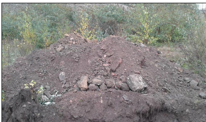
Vue n°102 : vue des déblais de la fouille V3
