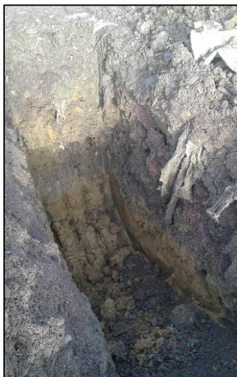
Vue n°97 : vue du sondage S18B
