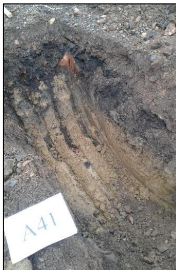
Vue n°73 : vue du sondage A41
