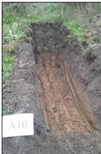
Vue n°19 : Vue de la fouille A10
