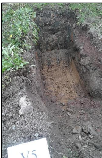
Vue n°105 : vue du sondage V5
