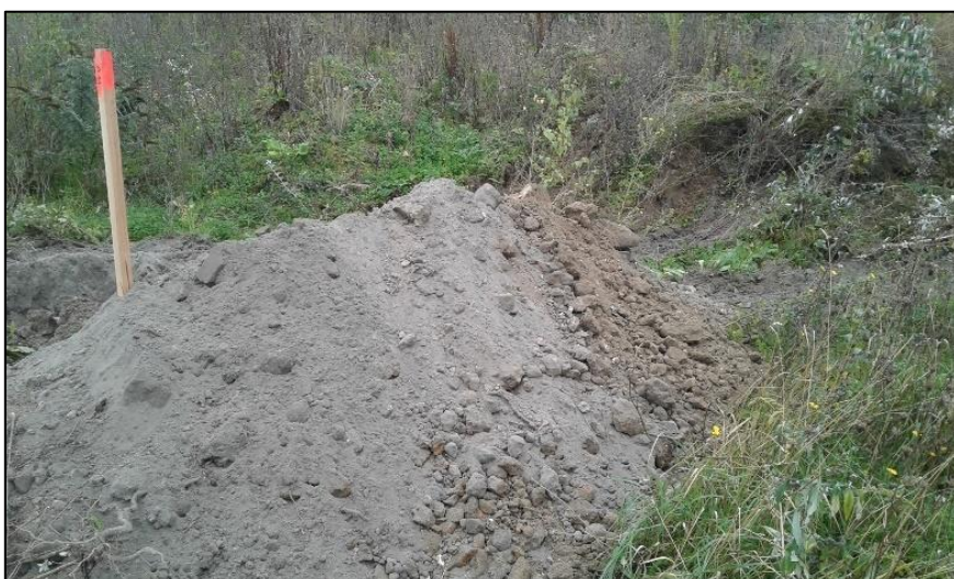
Vue n°22 : Vue des déblais de la fouille A11
