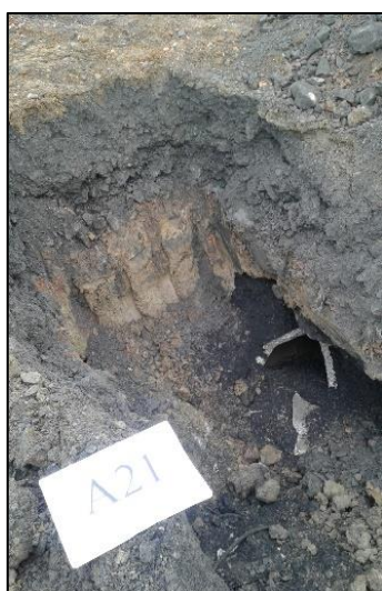
Vue n°41 : vue du sondage A21
