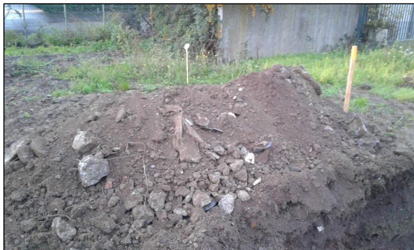
Vue n°146 : vue des déblais de la fouille V27
