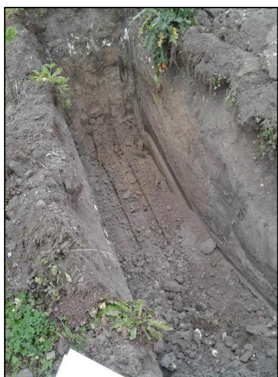
Vue n°11 : Vue de la fouille A6
