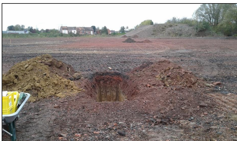
Vue n°120 : vue des déblais de la fouille V12
