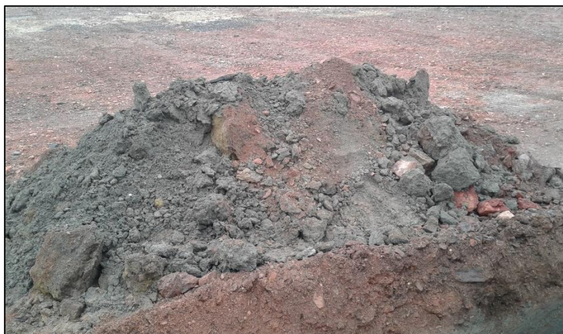
Vue n°118 : vue des déblais de la fouille V11
