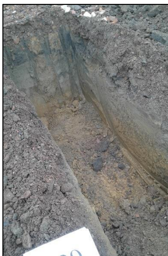
Vue n°131 : vue du sondage V20
