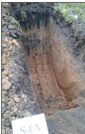
Vue n°81 : vue du sondage S4A
