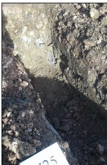
Vue n°141 : vue du sondage V25
