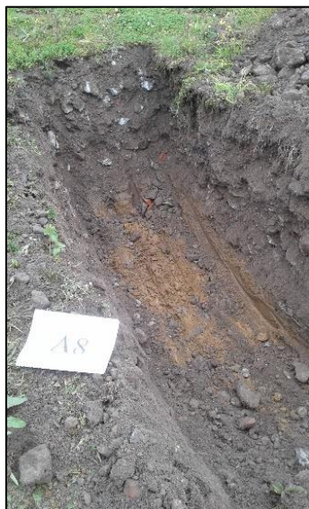
Vue n°15 : Vue de la fouille A8
