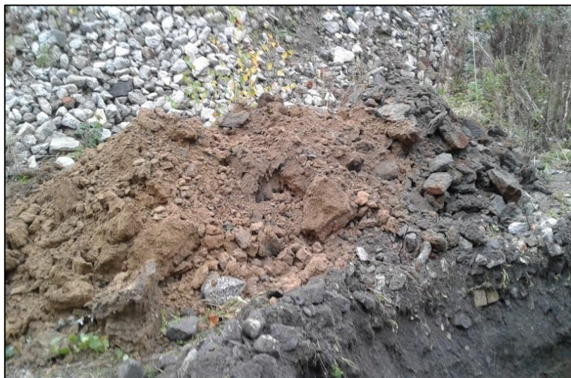
Vue n°8 : Vue des déblais de la fouille A4
